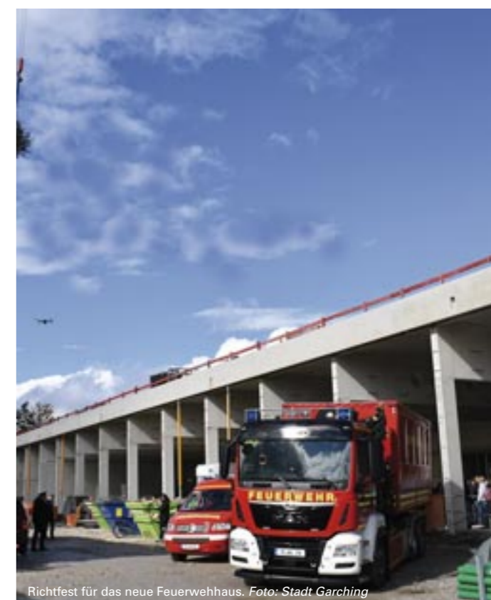
Richtfest für das neue Feuerwehrhaus. Foto: Stadt Garching
