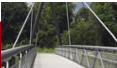
Geöffnet: Radwegbrücke über die Isar
